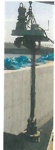
【切断機引抜き状況】
