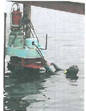
【切断機誘導挿入状況】
