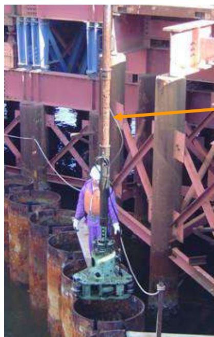
ディスクカッター鋼管杭挿入
