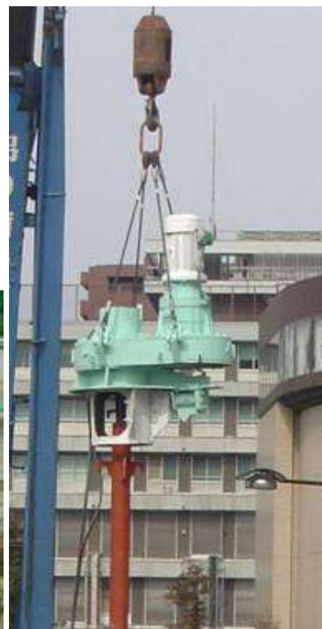
ディスクカッター鋼管杭挿入
