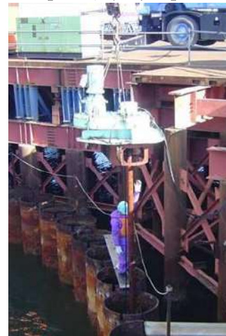
【切断機挿入状況】
