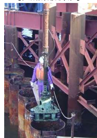
【切断機引抜き状況】
