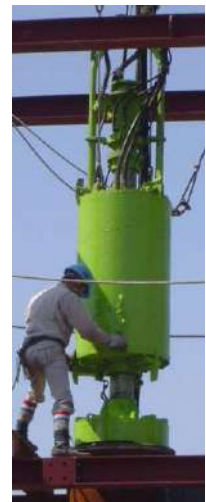
【切断機引抜き状況】
