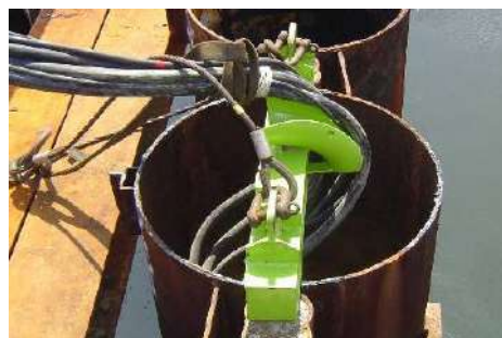
砥石カッター鋼管杭セット完了状況
