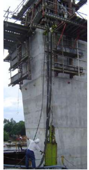
【切断機挿入状況】
