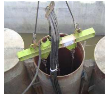
【鋼管矢板切断状況】
