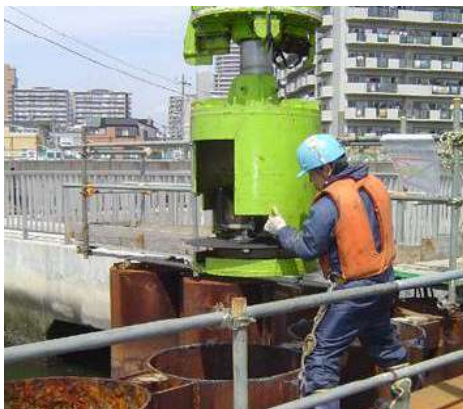
砥石カッター鋼管杭セット完了状況
